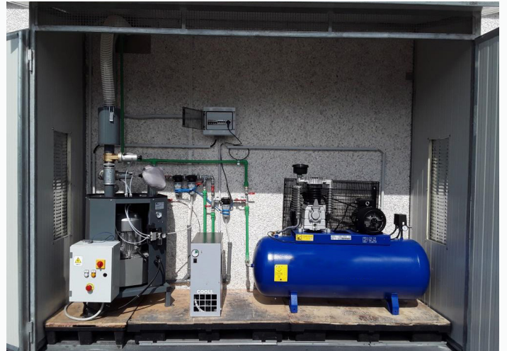
Förderanlagen mit Seitenkanalverdichter Separated side channel blower unit in technical environment
